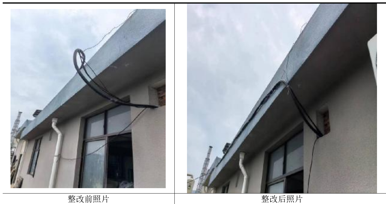
图 2.7-6 废气在线监控设备伴热管整改前后对比照片
