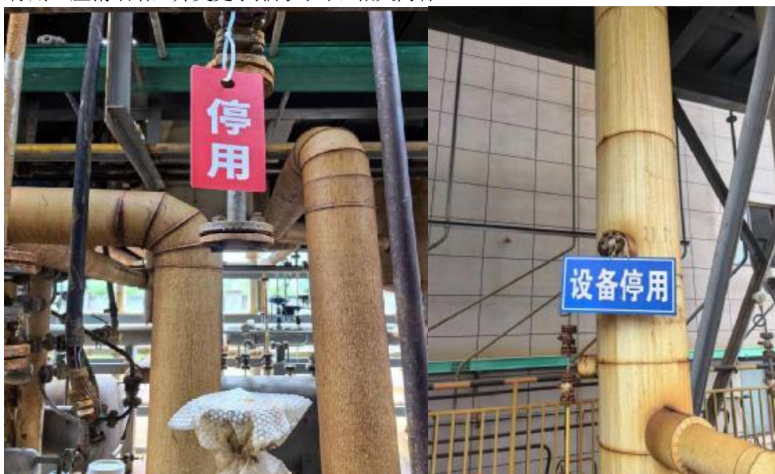
图 2.7-7 停用精馏塔现状照片
