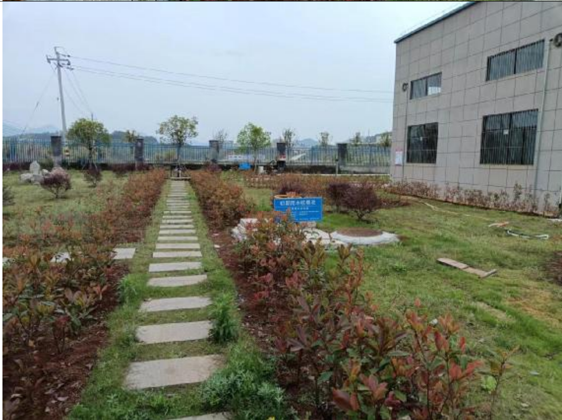
图 2.4-2 现有事故应急池与初期雨水收集池区域现状照片
