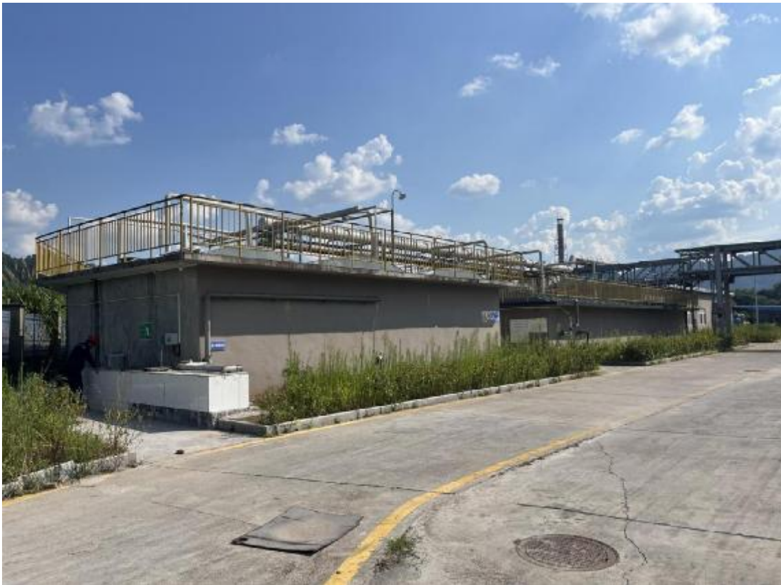
图 2.5-5 企业现有污水处理站现状照片
